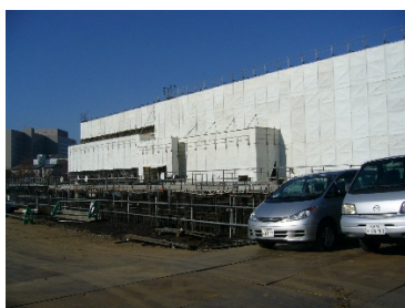
工事中の温室を含む棟
